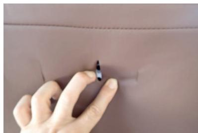
23 テーブルを固定するボルトの穴位置にカバーの切れ込みを入れていきます。(6箇所)カバーの切れ込みとボルト穴の位置が合っていることを確認して下さい。合っていない場合はカバーの装着がずれている可能性があります。その場合はカバーの装着を見直して下さい。
